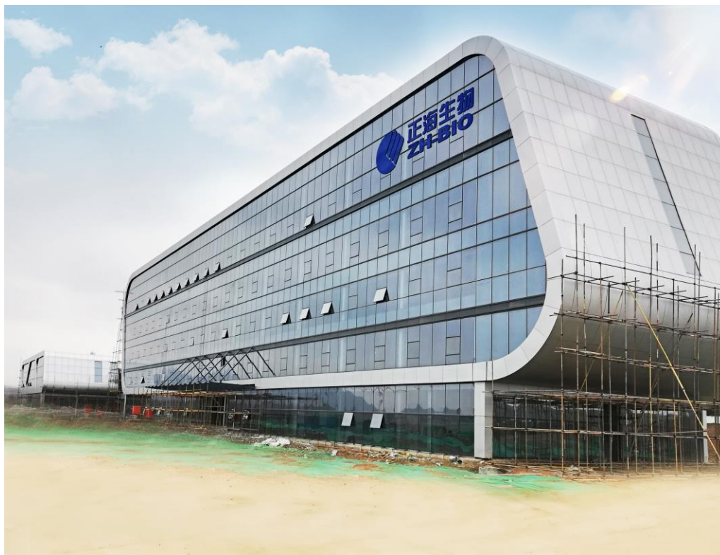
图六：公司新厂区主体建筑实拍图
